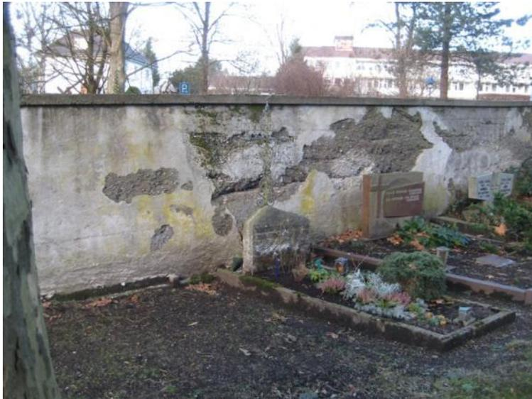
In Abschnitten wurde der Efeubewuchs entfernt, um den Sanierungsbedarf der Mauer feststellen zu können.
