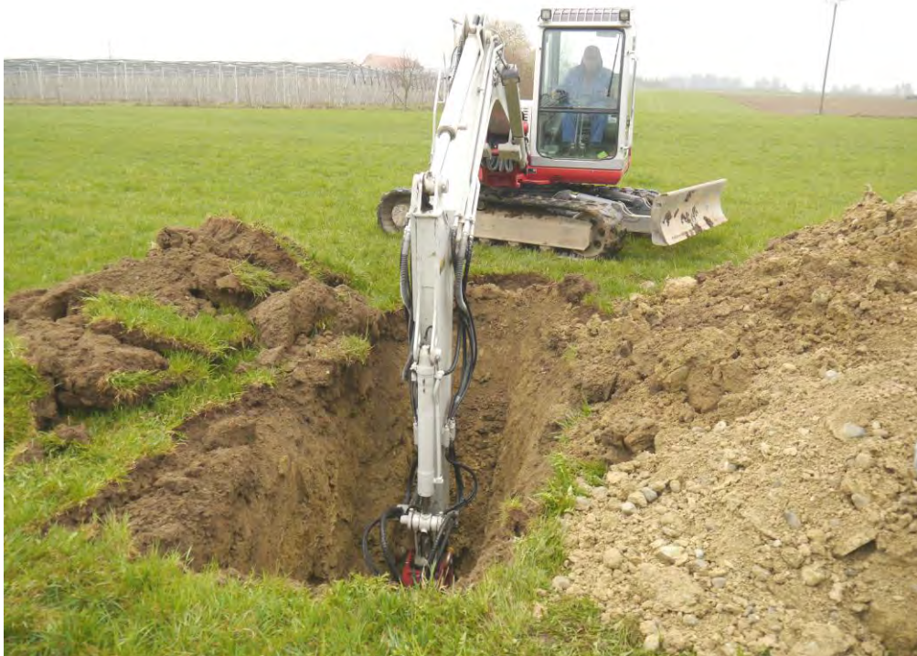
Abb.3: Herstellung Schurfgrube SG 2/14, Brachwiese, Schmalegg
