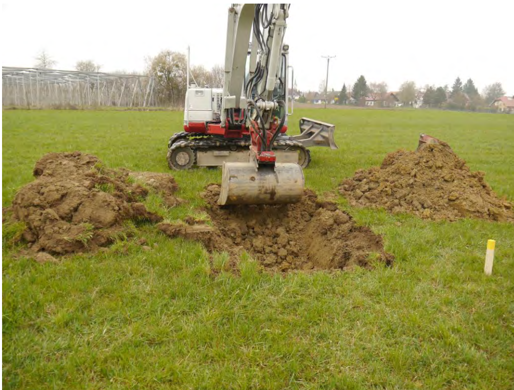
Abb.1: Herstellung Schurfgrube SG 1/14, Brachwiese, Schmalegg
