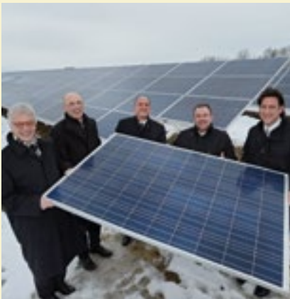
29. Januar: Die Photovoltaikanlage Boms-Haggenmoos geht in Betrieb.
