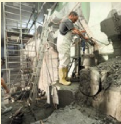
März bis Dezember: Über das Jahr wurde der Hochbehälter Fildemoos grundlegend saniert.
