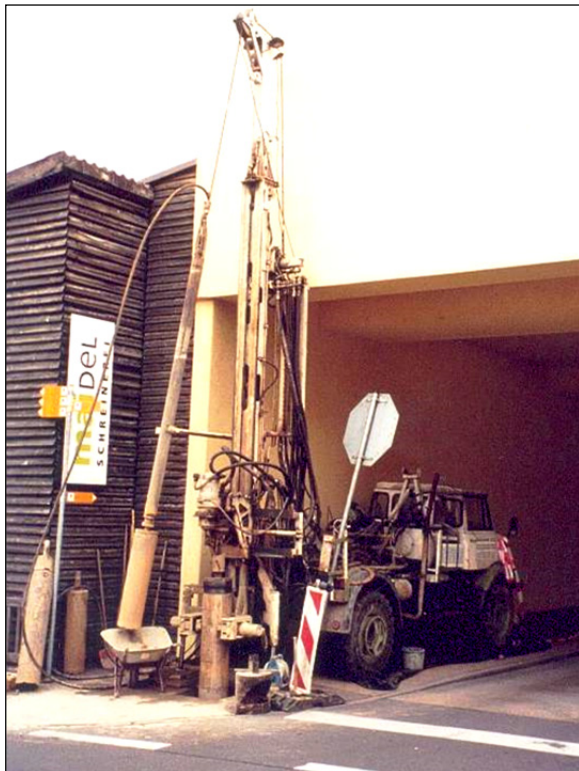
Abbildung 5-6: Vorschachtung (rechts) und Bohrarbeiten unter für Innenstadtvhältnisse typischen engen Platzverhältnissen (links)
