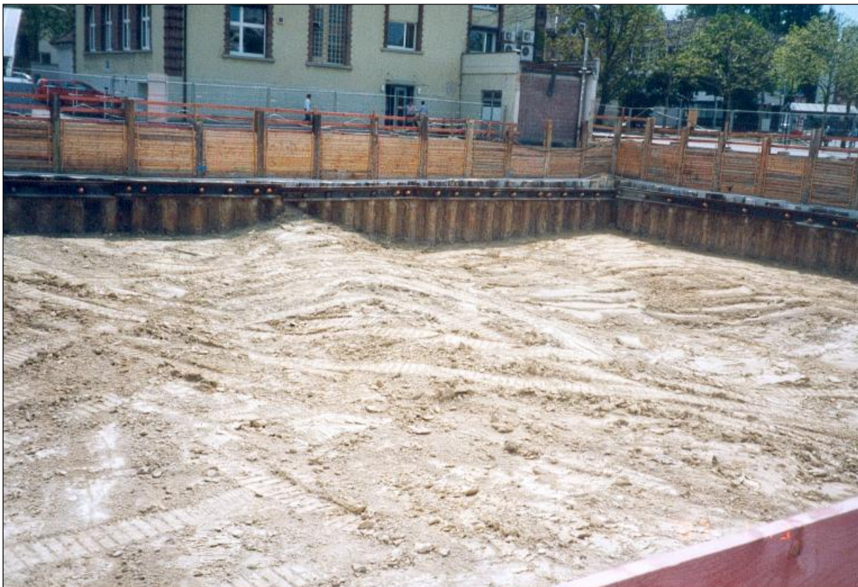
Abbildung 4-10: Blick auf die Rinnenstruktur der freigelegten Aquiferbasis während der Sanierung des ehem. Gaswerks Ravensburg
