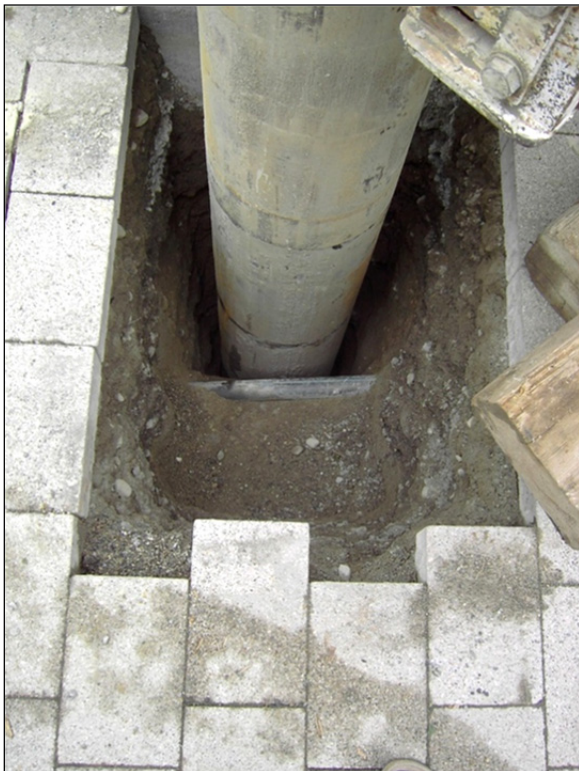
Abbildung 5-6: Vorschachtung (rechts) und Bohrarbeiten unter für Innenstadtvhältnisse typischen engen Platzverhältnissen (links)
