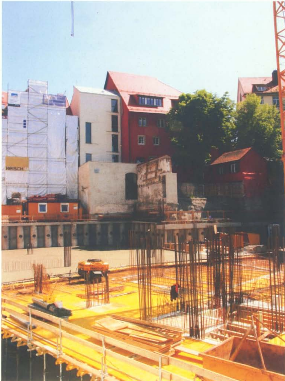
Fortgang der Rohbauarbeiten am Kunstmuseum
