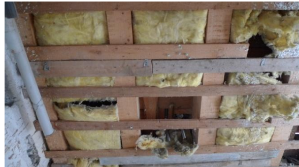
Bild 7: Unfachmännischer 80er-Jahre Einbau
