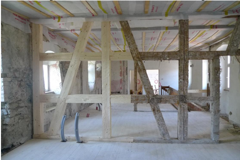
Bild 13: Weitgehend sanierter Bereich mit neuem Boden und Decke, sowie neuen Leitungen
