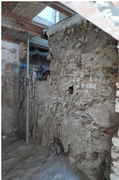
Bild 8: fehlende Auflager
