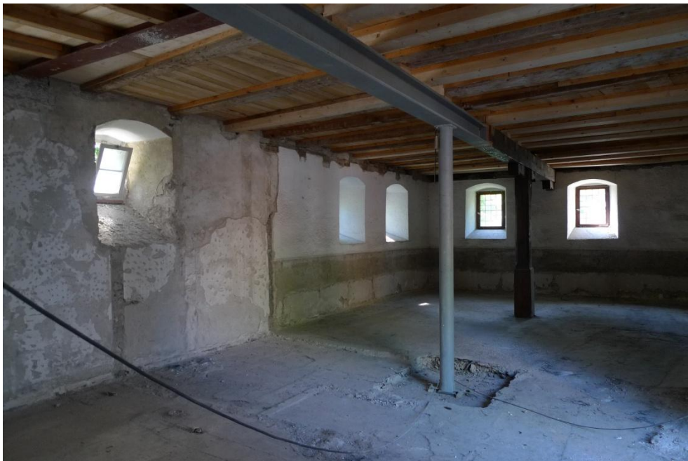
Bild 14: Zukünftiger Speisesaal (Rittersaal) mit statischer Ertüchtigung
