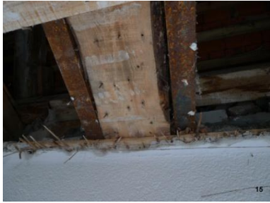
Bild 3: rostender Stahl (80er-Ja.) Bild 4
