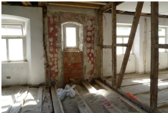
Bild 8: fehlende Auflager
