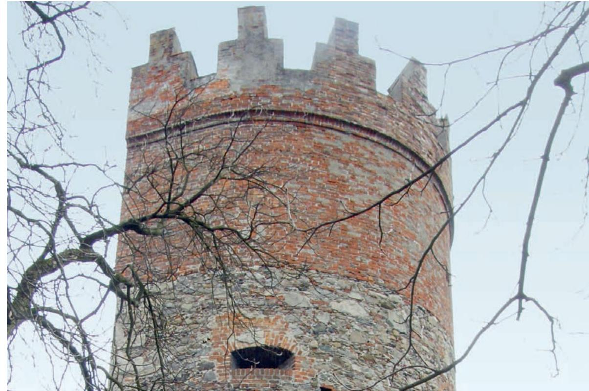
sichtbar – Spuren alter Reparaturflächen für Fehlstellen oder gar Reste eines ehemaligen Verputzes? **4**
