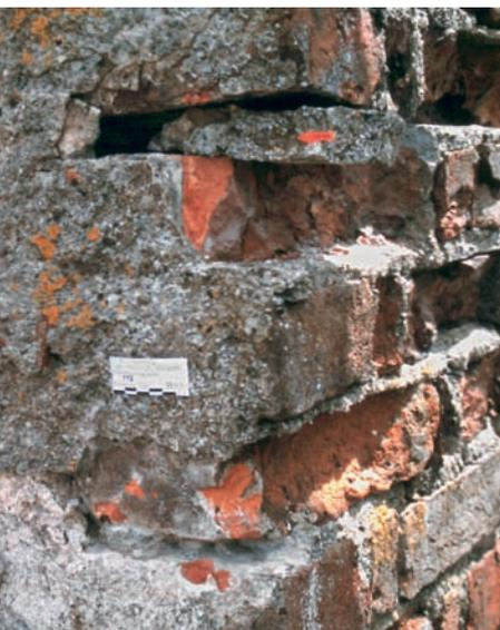
5 Stufenweise Schalenbildung mit Abplatzungen im oberen Backsteinbereich (Foto: D. Colic)
