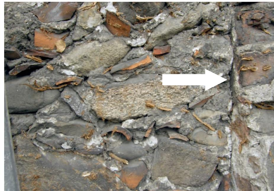
**8** Nachweis Kalkverputz Stadtmauer an Baufuge Turmwand (links) und Stadtmauer (rechts)
