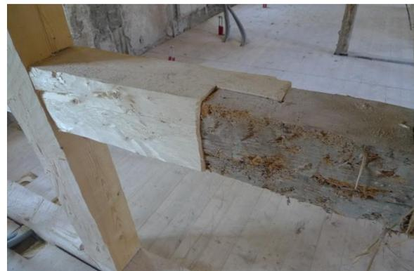
Bild 12: Verbindung zwischen Alt und Neu
