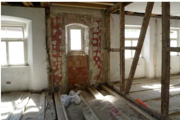
Bild 11: Schüttung für den Schallschutz
