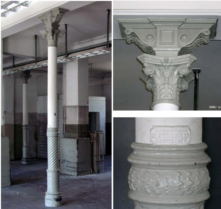
[ Alte Gusseiserne Stützen in der früheren Schalterhalle – rechts Mittelteil ]
