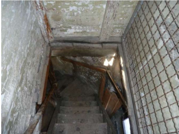
Zugang zum nicht öffentlichen Bereich
