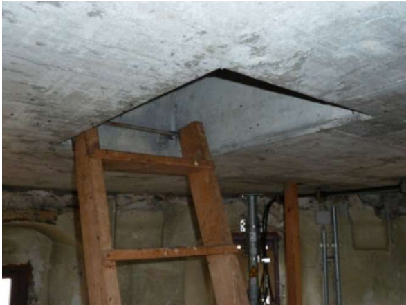
Zugang DG – Betondecke
