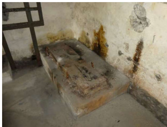
Sockel ehem. Motoren und Antriebe
