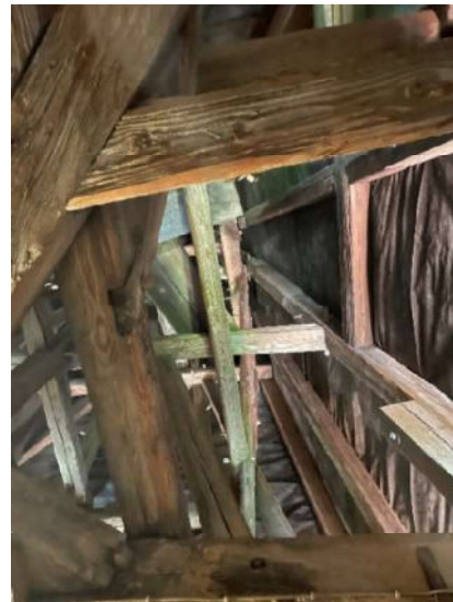
Blick Richtung Dachspitze
