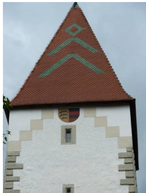
Zierelemente mit glasierten Ziegeln
