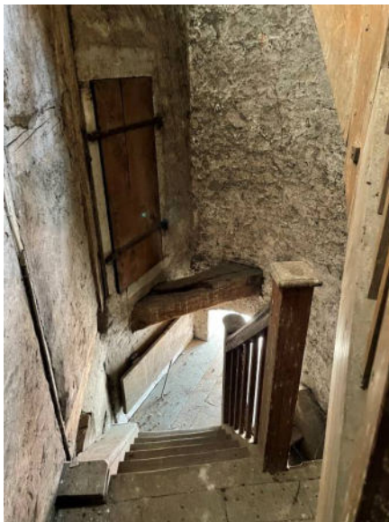
Treppenhaus mit Feuerungsöffnung
