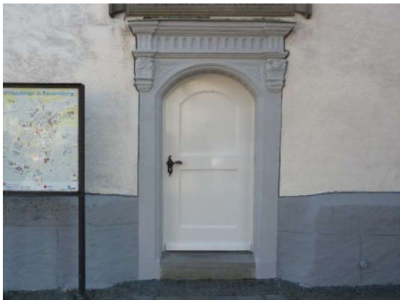
Neu gestrichenes Eingangsportal
