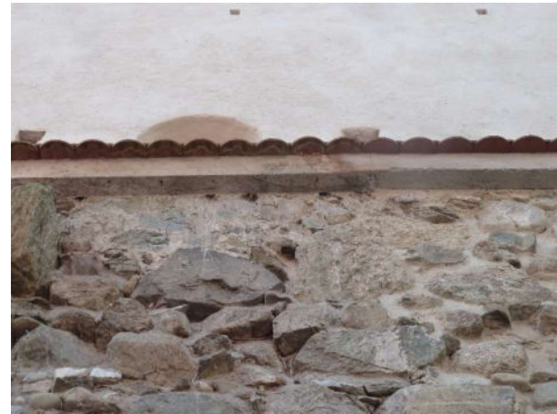
Übergang Mauer – Turm
