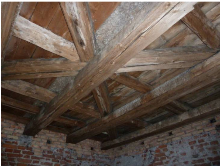
Untersicht der Dachkonstruktion
