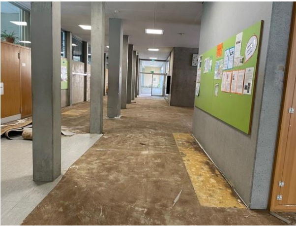
Bodenbelag Foyer – Vor Umbau
