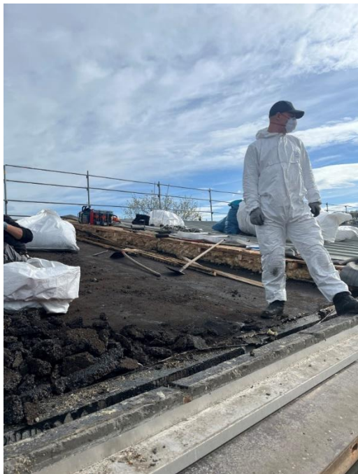
Alte Bitumenschichten
