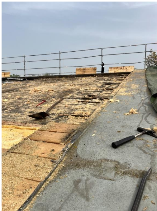
Durchfeuchtete Dachunterkonstruktion
