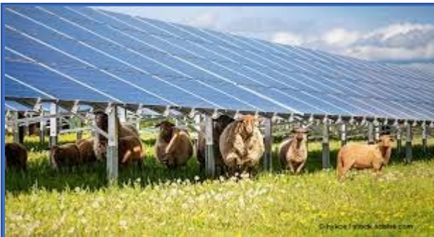
Erweiterung Solarpark von 5 auf 13 MWp
