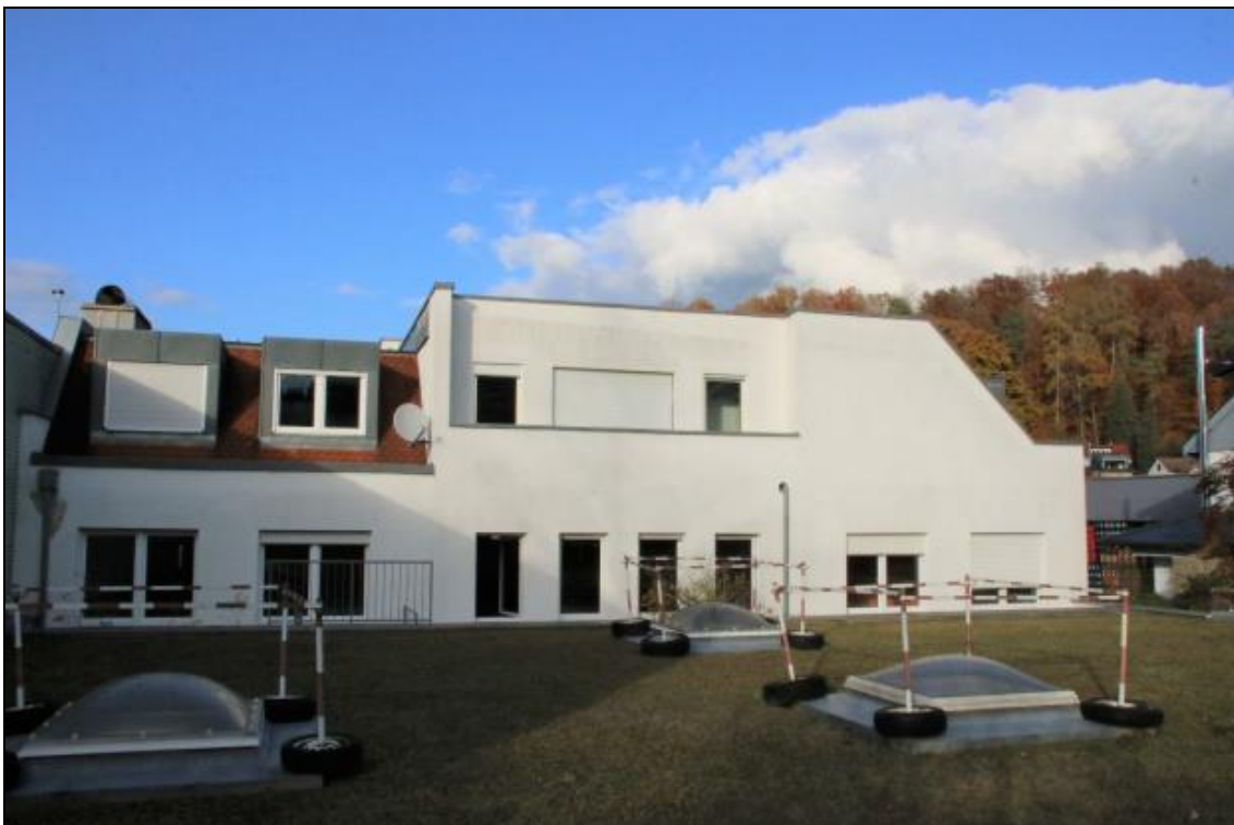
Abbildung 3: Gebäude 2, Ansicht von Süden.
