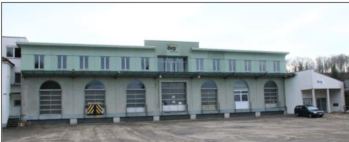
Abbildung 7: Gebäude 5 (Gewerbehalle), Ansicht von Norden.
