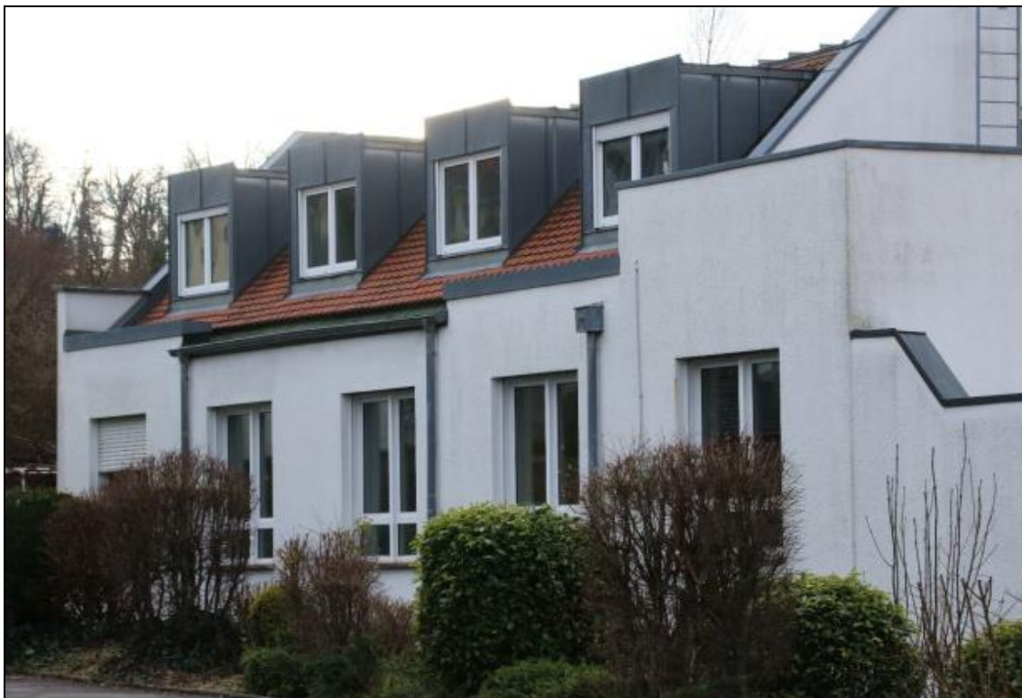
Abbildung 4: Gebäude 2, Ansicht von Osten.
