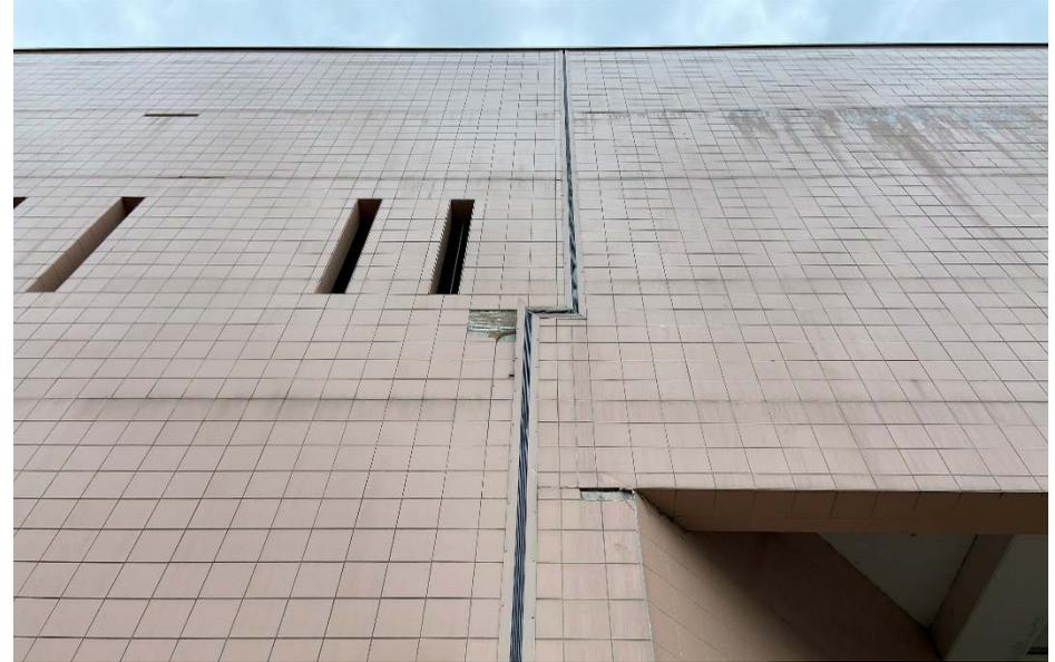
Die Fliesendeckschicht stellt nach Bauschadensbild eine Verkehrsgefährdung dar und muss dringend saniert werden.
