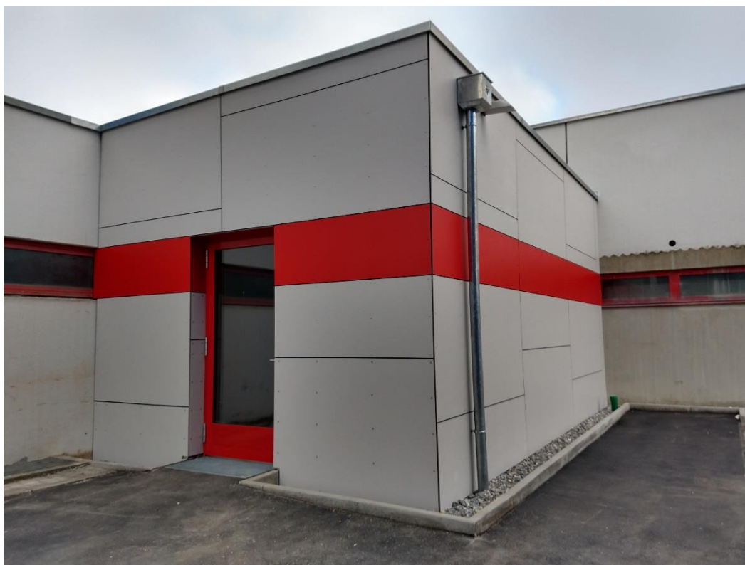
Anbau Technikgebäude an das Betriebsgebäude Schlammwässerung
