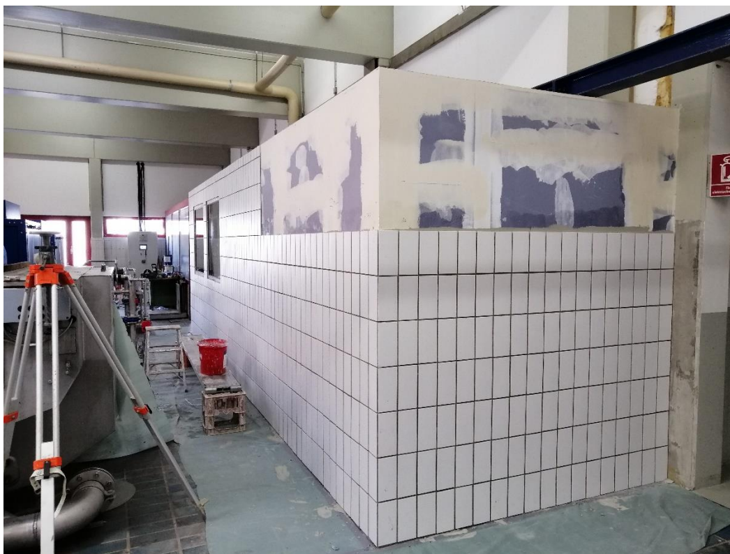
Anbau Technikraum Innenbereich Schlammwässerung
