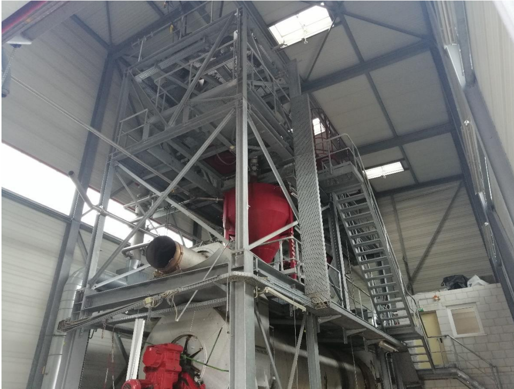
Rückbau Klärschlamm-Trocknungsanlage
