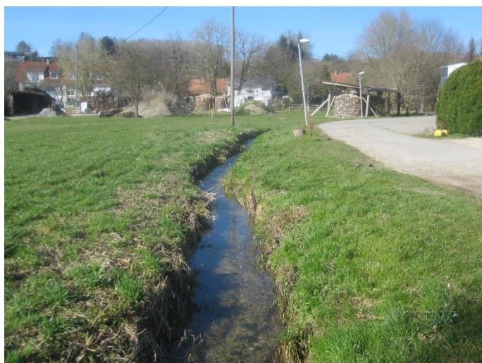
Foto 1: Gewässerprofil Station 0 + 725,00 Blick nach oberstrom
