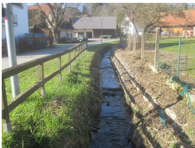
Foto 5: Station 0 + 874,47 Stockerholzbach oberstrom Einlauf DN 1600
