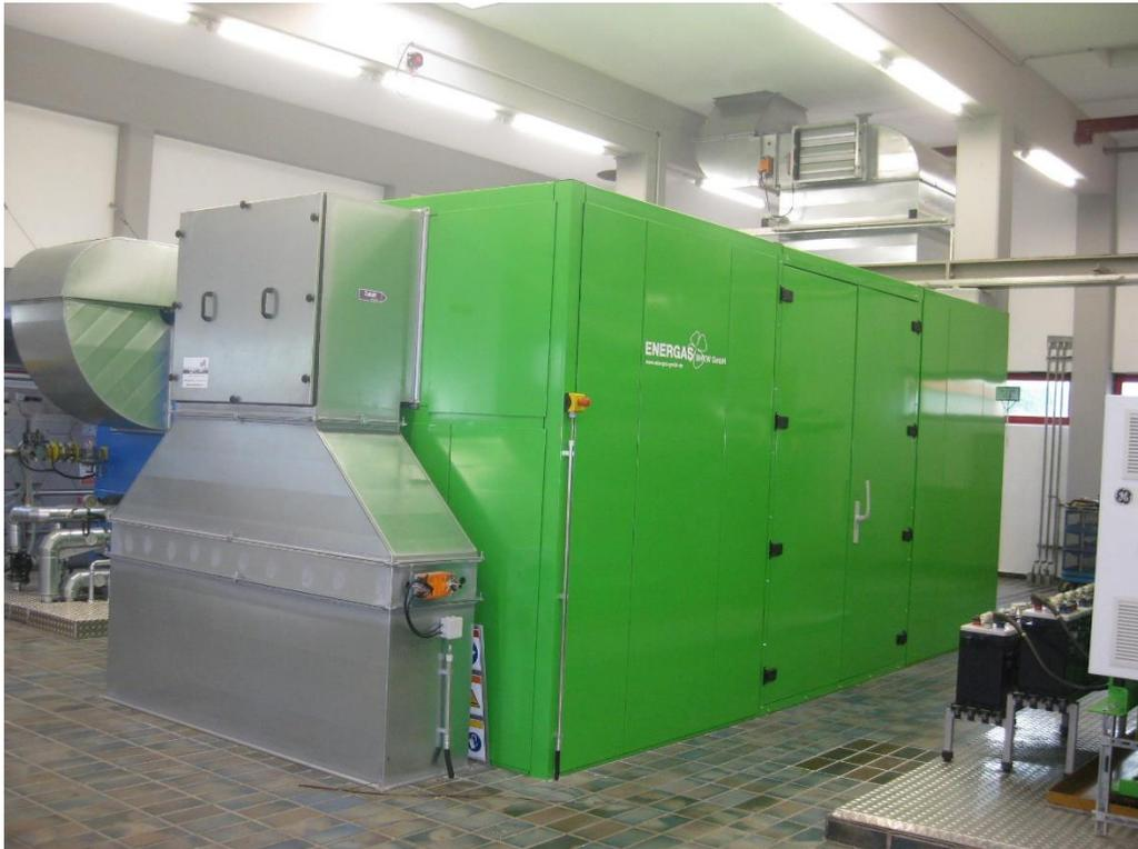
Neu installiertes Blockheizkraftwerk mit Schallschutz
