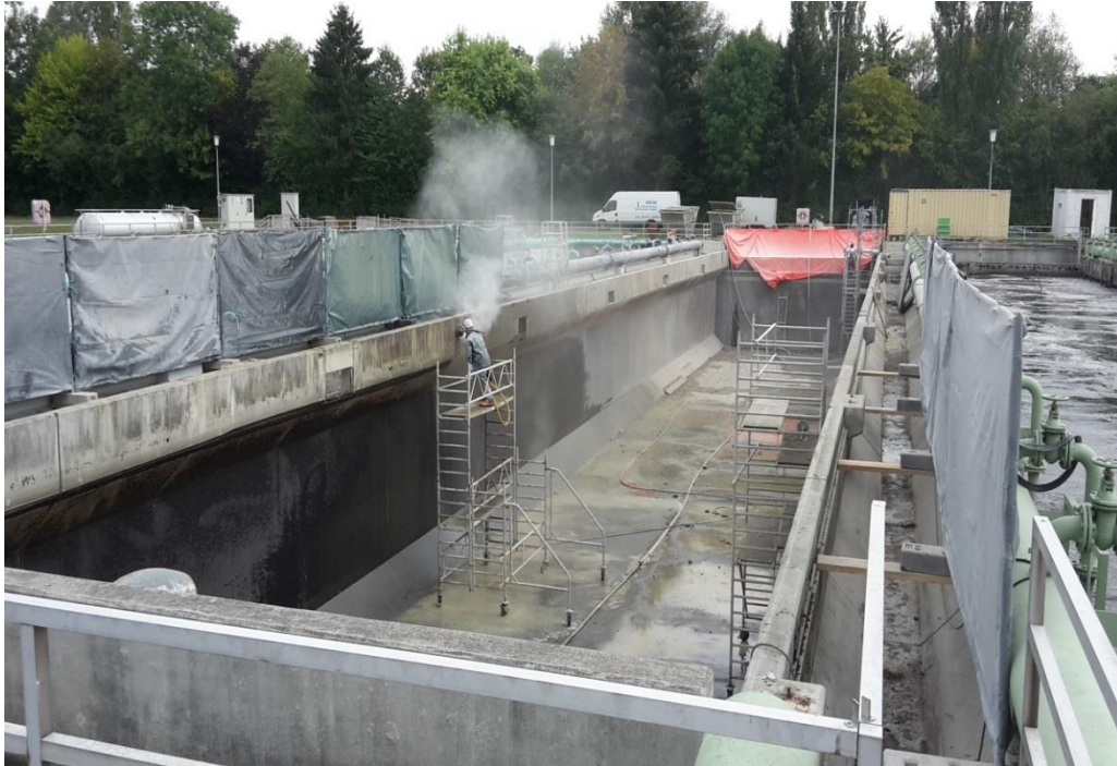
Betonsanierungsarbeiten Belebungsbecken 4
