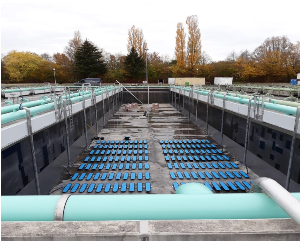
Einbau Flächenbelüfter in das sanierte Belebungsbecken 3
