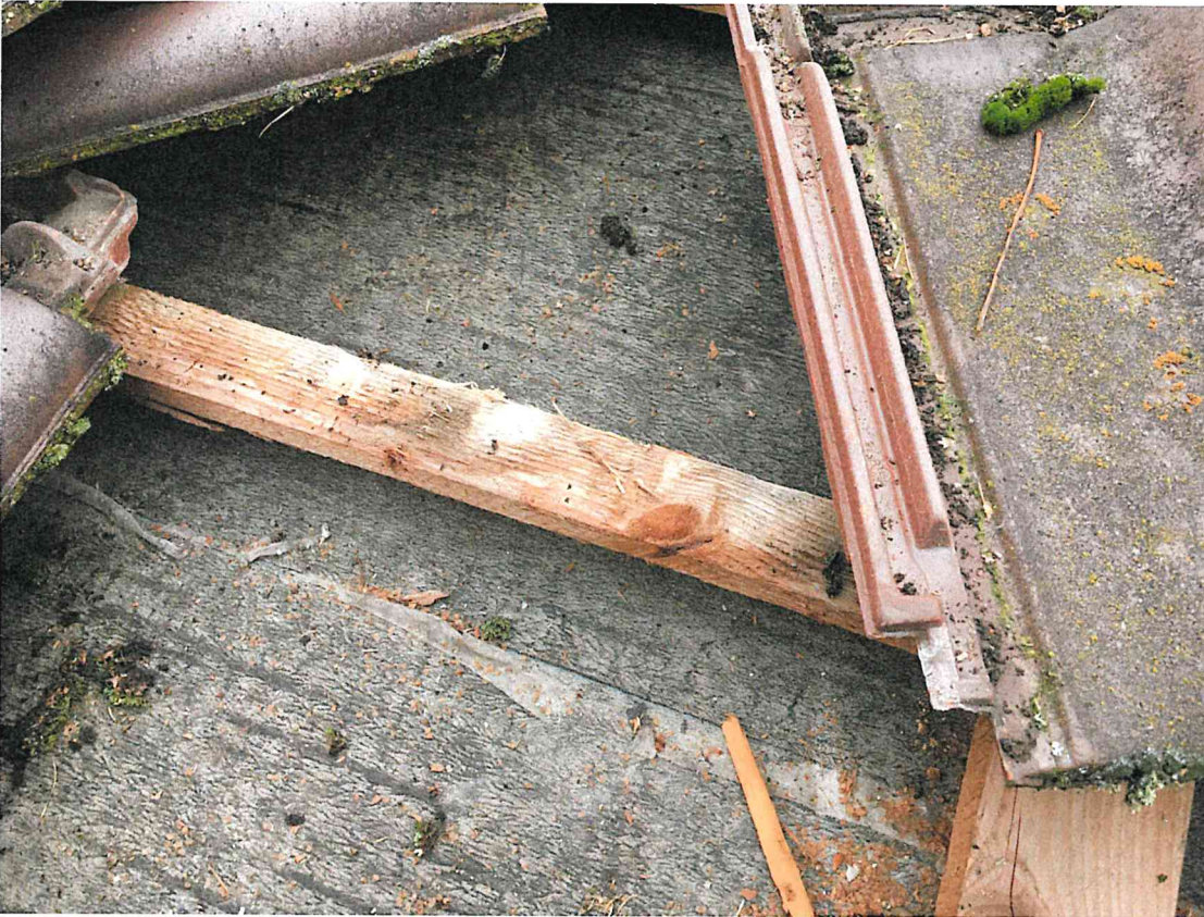
Dachaufbau oben, Ziegeldeckung, Lattung, Konterlattung, dampfdichte Schalungsbahn
