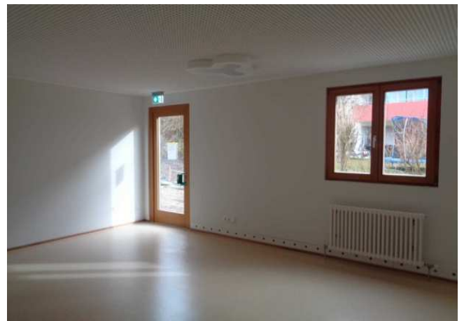
Schlafräum mit neuer Akustikdecke und Sockelheizung
