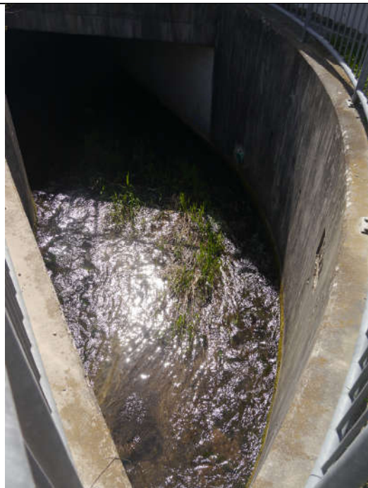
Gefasster Bereich des Stadtbachs an der östlichen Plangebietsgrenze
