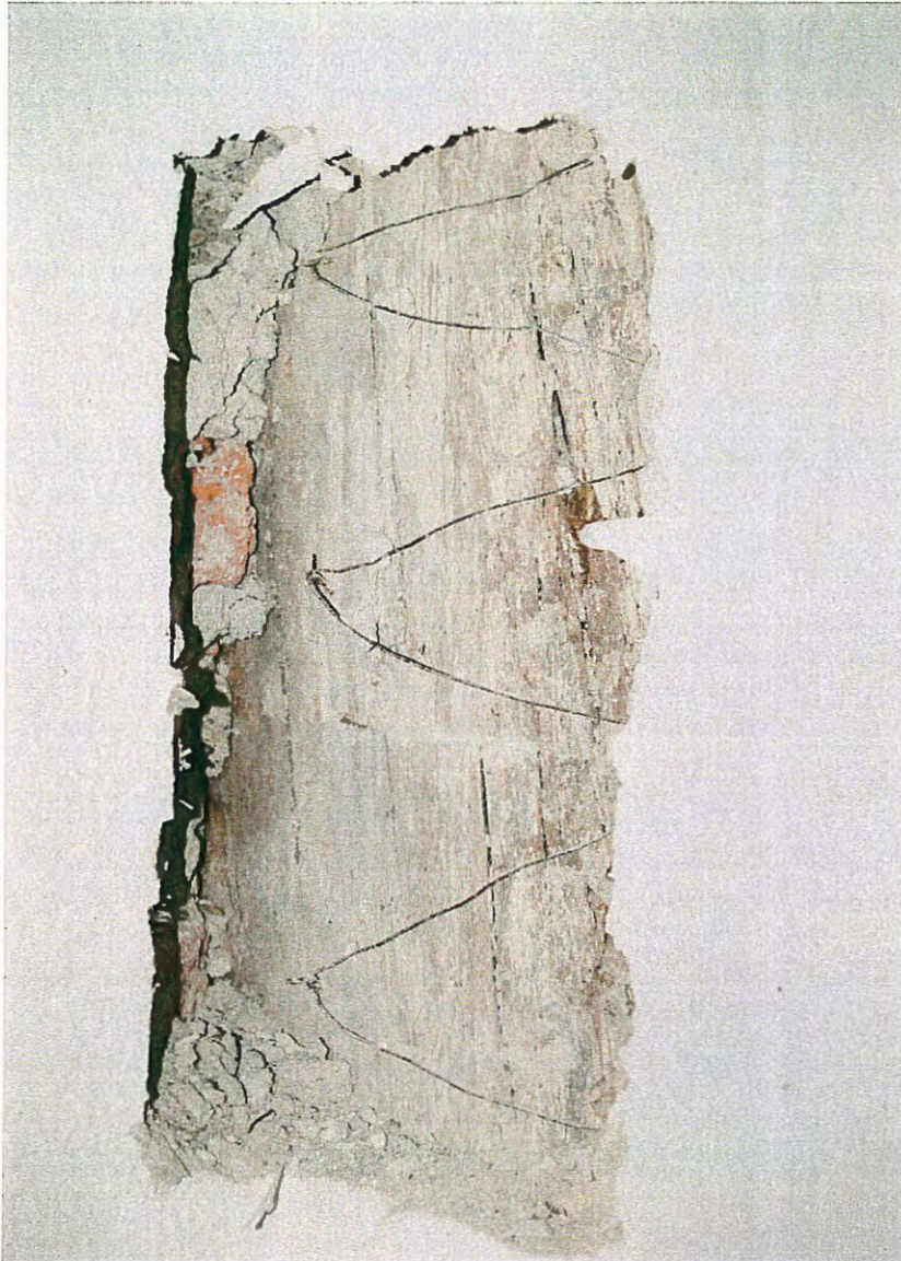
Abb. 4 Obergeschoß, nordöstlicher Eckraum. Sondage in der Nordostecke mit mittelalterlichem Bundständer aus Eichenholz.
