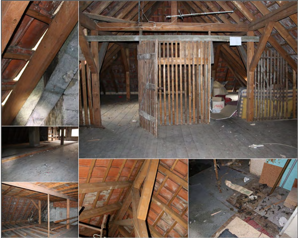
Abbildung 9 Dachstuhl Räuberhöhle. Fotos vom 16.06.2015.
