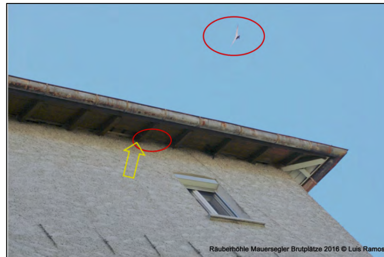
Abbildung 5 Weiterer Brutplatz Anbau Räuberhöhle Mauersegler mit Brutpaar: gelber Pfeil Anflug eines Mauerseglers Brutplatz, roter Kreis mit fliegendem Individuum. Foto Ramos vom 22.06.2016.
