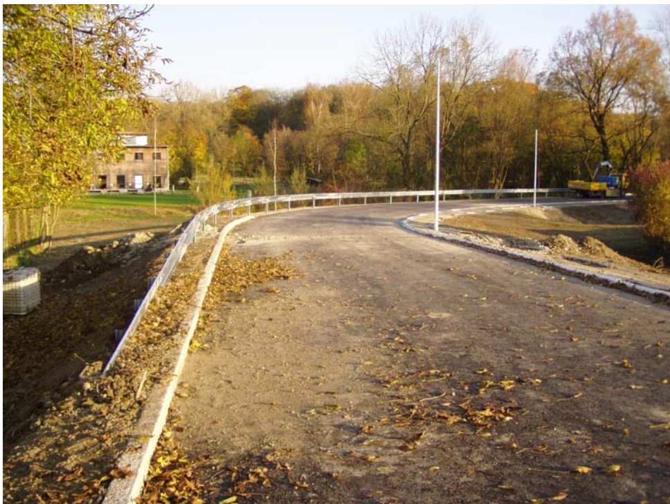
Ausbau an der Bleicherei
