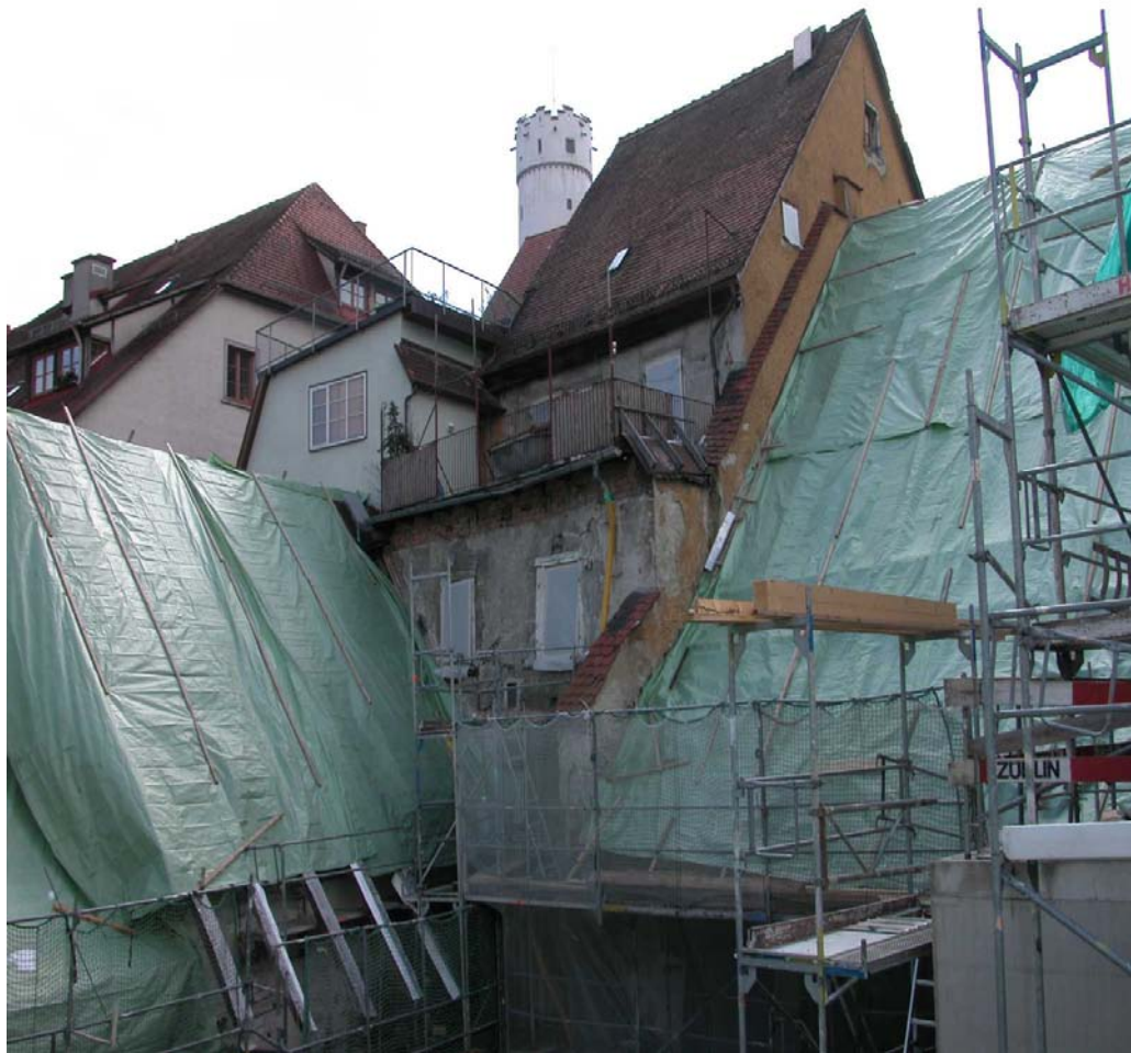
Fortführung der Bauarbeiten im Innenhof Museum Humpis-Quartier
