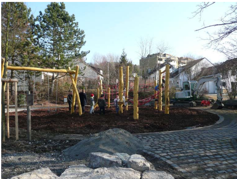
Sanierung Spielplatz Ludwig-Erlanger-Anlage
