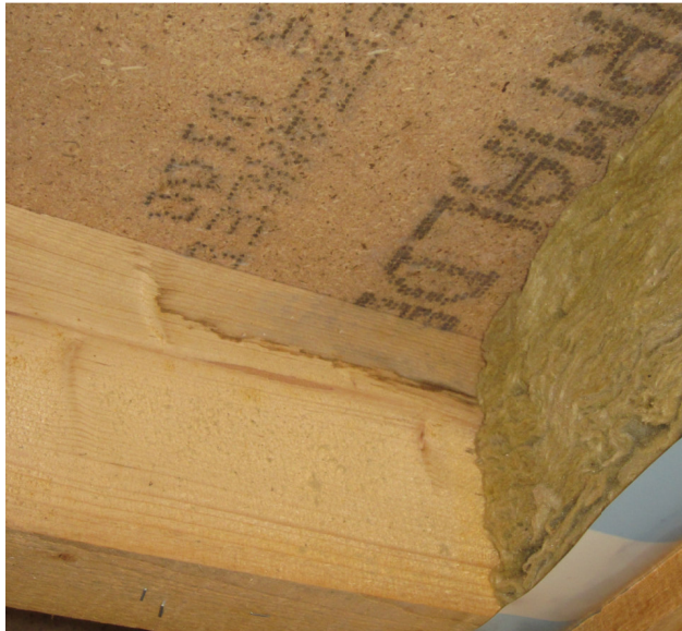
Bild 1: Öffnung 1 (Feuchtigkeitsspuren)
