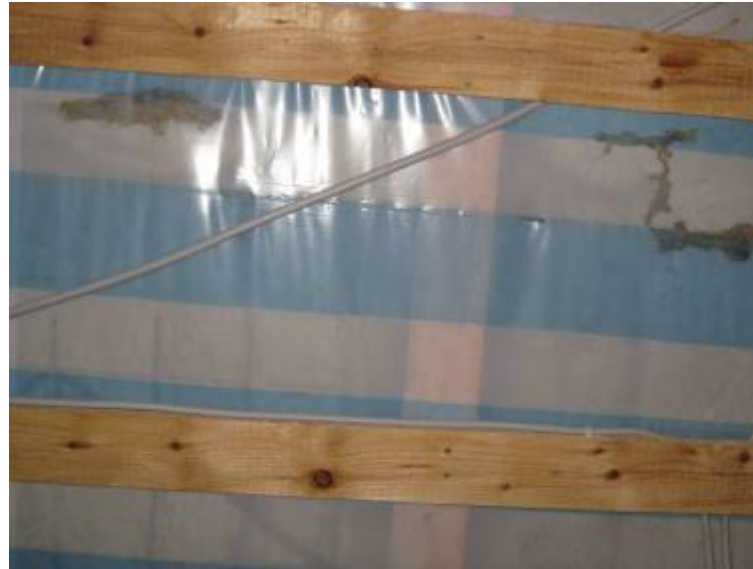
Bild 6: Dampfsperre Flur-// Durchgangsbereich
