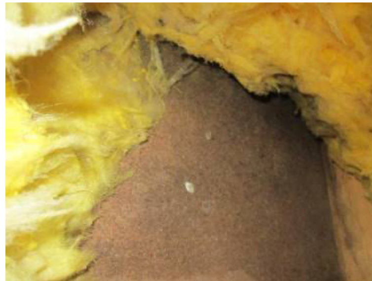
Bild 10 Öffnung 7 (Mineralfaser Pilzspuren)
