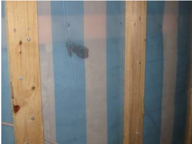
Bild 5: Dampfsperre Ausbau WC, Urinale
