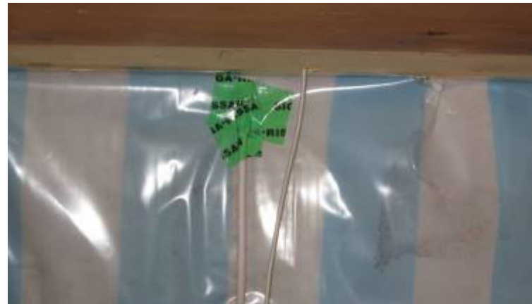
Bild 2: Dampfsperre ehem. Multifunktionsraum
