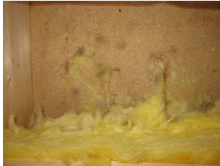
Bild 22: Öffnung 14 (leichte Stockflecken auf Spanplatte)
