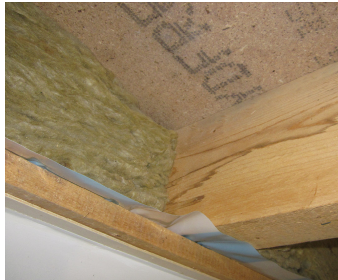
Bild 2: Öffnung 1 (Feuchtigkeitsspuren)
