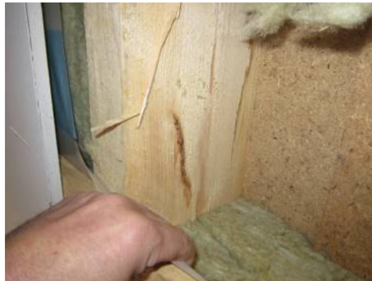
Bild 6: Öffnung 3 (Feuchtigkeitsspuren)
