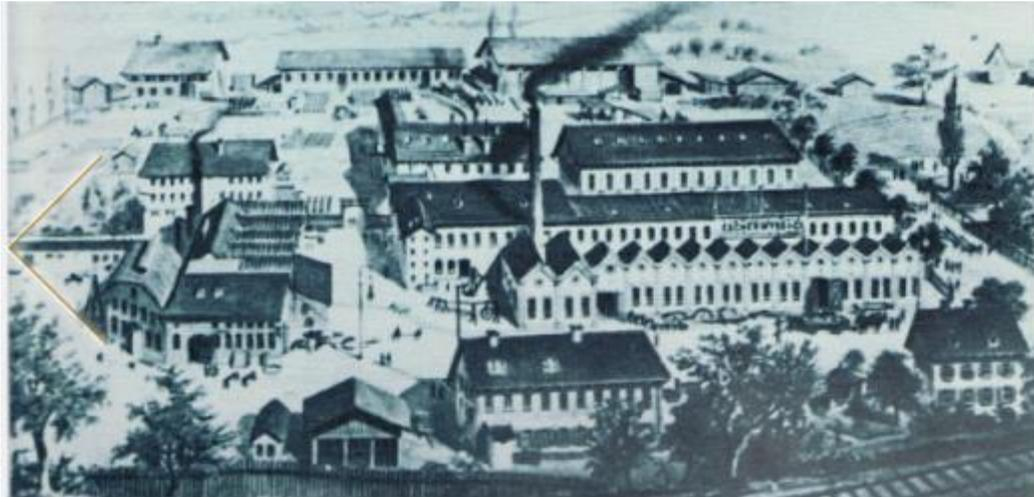
Neue Werkshallen entstanden um 1900, die betriebliche Infrastruktur wurde durch den Umbau der Schmiede und Schreinerei und der Errichtung einer eigenen Wasserkraftanlage entscheidend verbessert.
