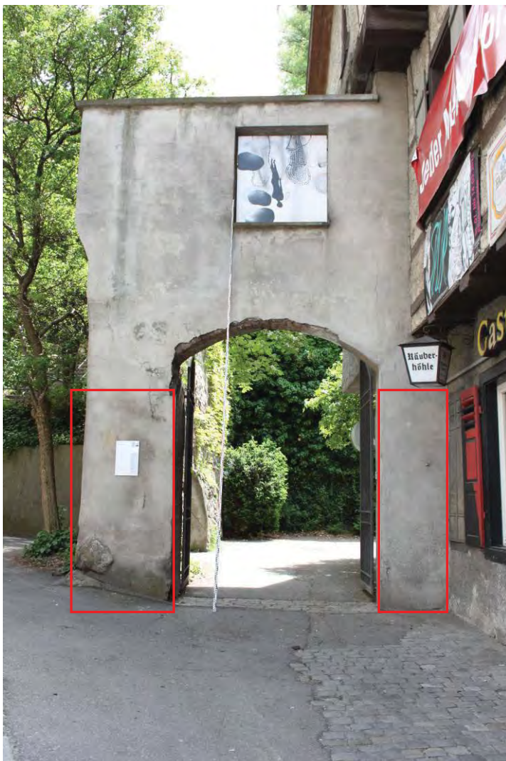
F_003: Torbogenmauer, Straßenseite. Umrahmt: Torbogenpfeiler (Befundeinheit 02). Links der nördliche, rechts der südliche.
