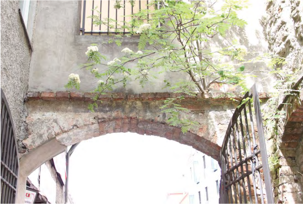
F_007: Torbogenmauer, Bogen von Osten
