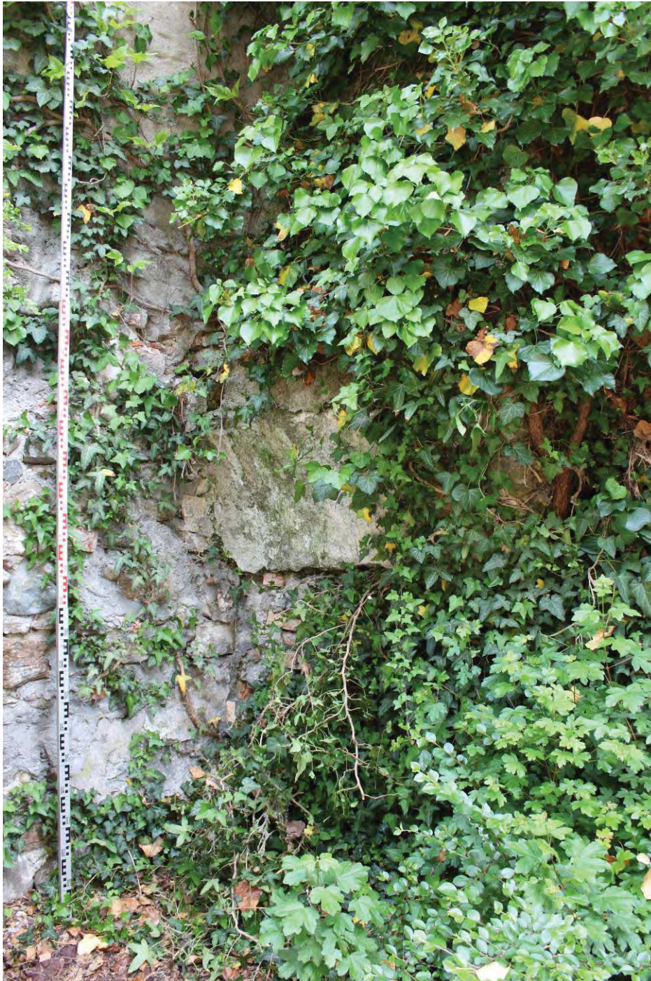
F_021: Innenecke Nordmauer-Hangmauer, Gewölbeansatz (Befundeinheit 09)
