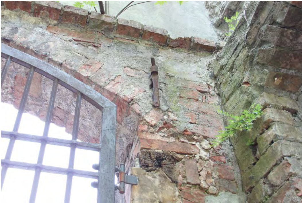
F_009: Torbogenmauer, nördlicher Bogenansatz von Osten.
