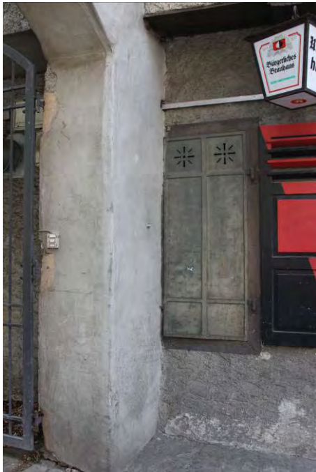
F_004 (oben links): Südlicher Torbogenpfeiler, Überdeckung des Fensterrahmens am Gebäude Burgstrasse 14
