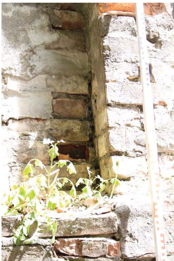
F_016: Nischen-Wandschale, nachträglich eingesetzte Rückwandschale der westlichen Nische.
