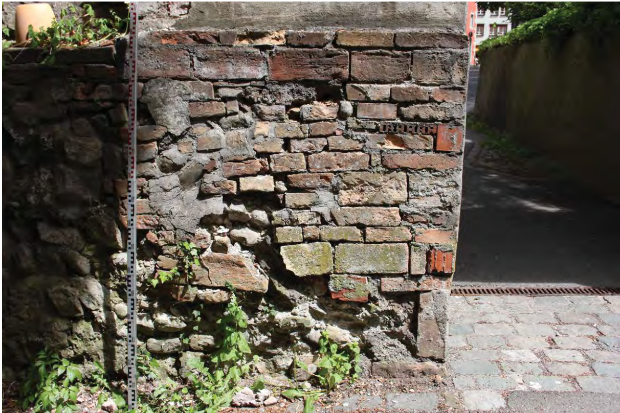
F_018: Nordmauer, westlicher Abschnitt, Befundeinheit 01 mit Überarbeitung durch vorgeblendete Backsteine / Ziegel.
