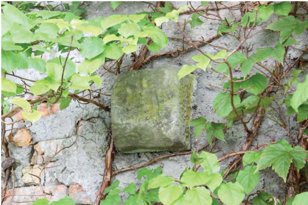
F_022: Hangmauer, Konsole
