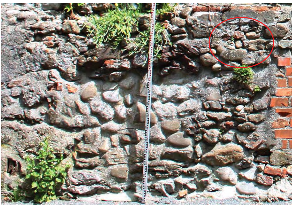
F_002: Nordmauer, mittlerer Abschnitt, Detail Mauerbild. Umrahmt: Mögliche ehemalige Ansichtsfläche.
