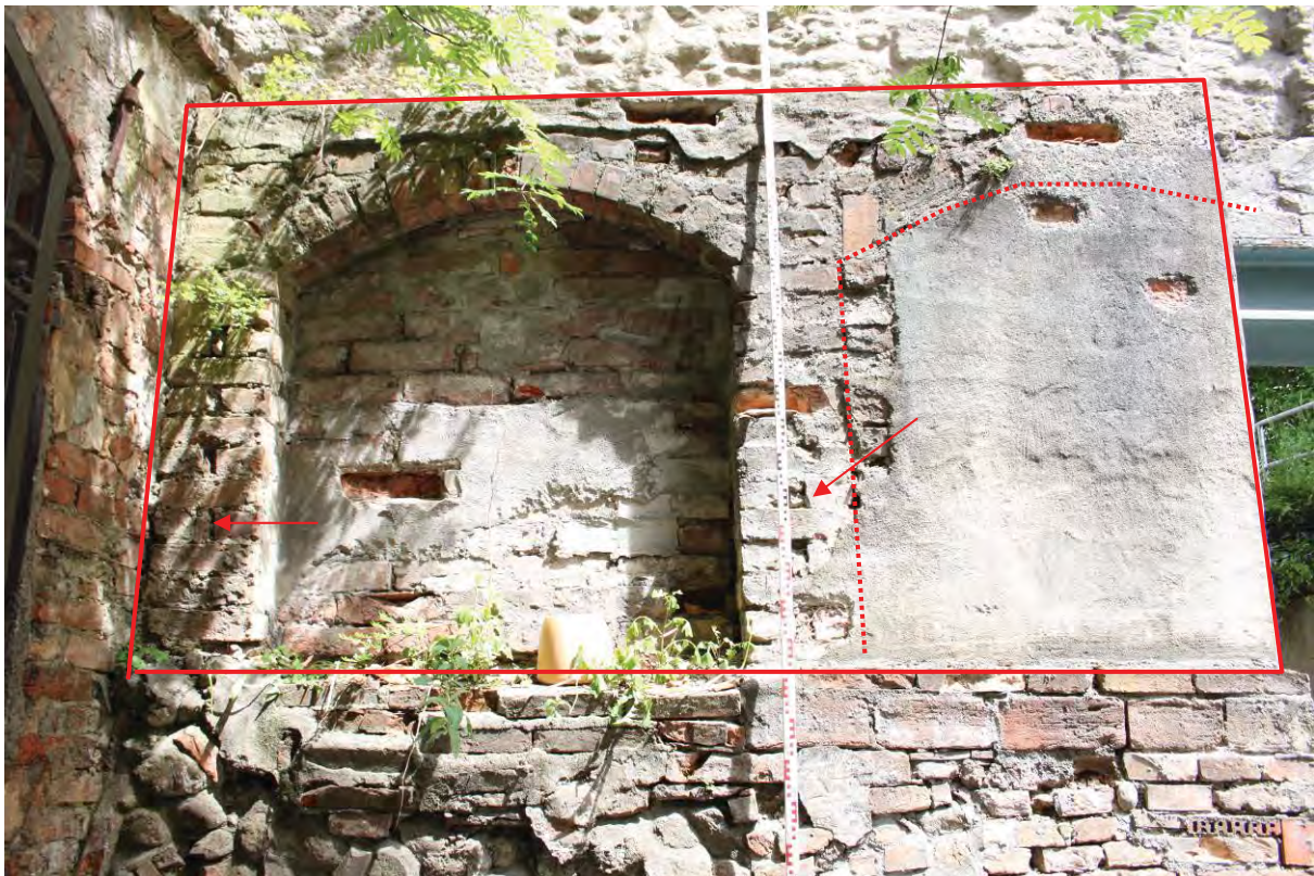
F_014: Nordmauer, aufgesetzte, gemischte Mauerschale. Aufgrund der geringen Binderbreite von nur 13cm mussten im Falle der Nischenpfeiler die Binder in jeder 2. Schicht durch ein in die Fuge geklemmtes Ziegelstück ergänzt werden (Pfeile: Beispiele). Punktlinie: zugesetzte östliche Nische.
