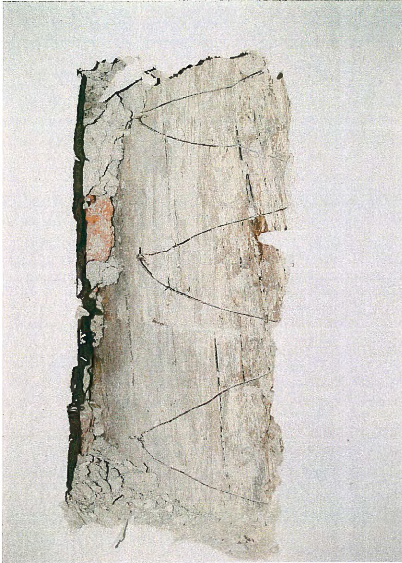
Abb. 4 Obergeschoß, nordöstlicher Eckraum. Sondage in der Nordostecke mit mittelalterlichem Bundständer aus Eichenholz.
