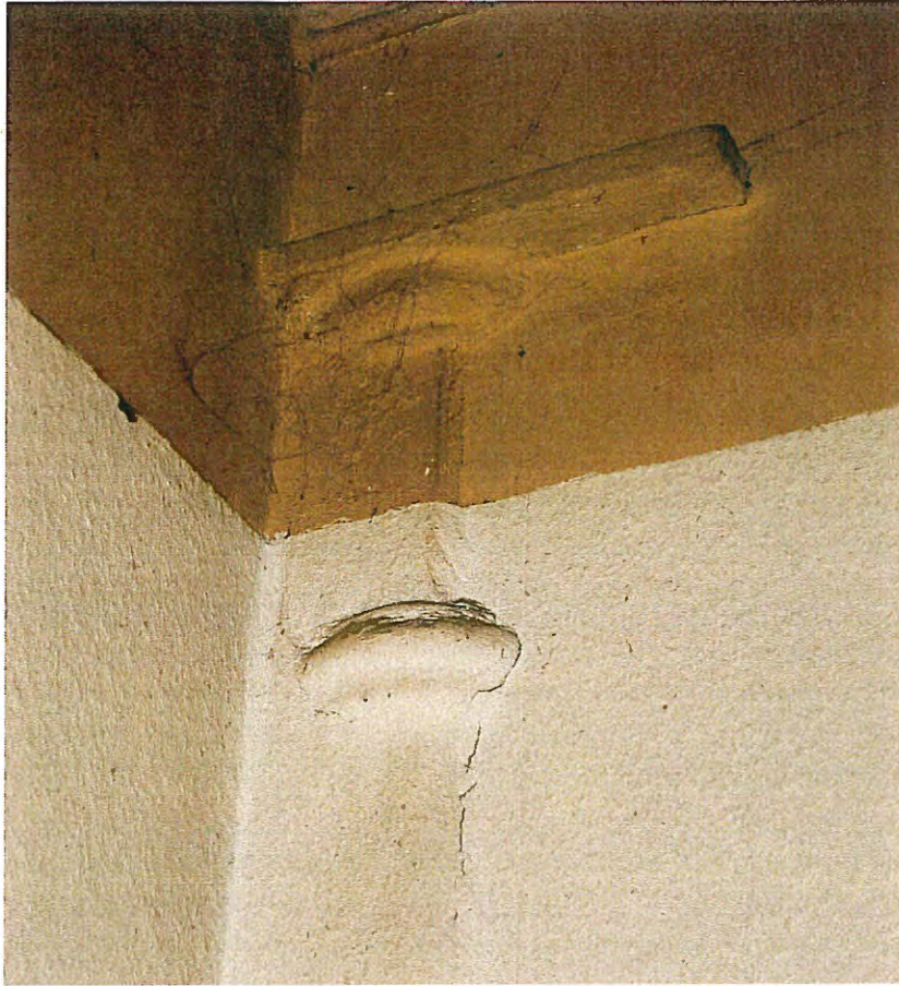
Abb. 1 Erdgeschoß. Gußeisene Säule in der Südwand des südlichen Eingangsflures an der Westseite.
