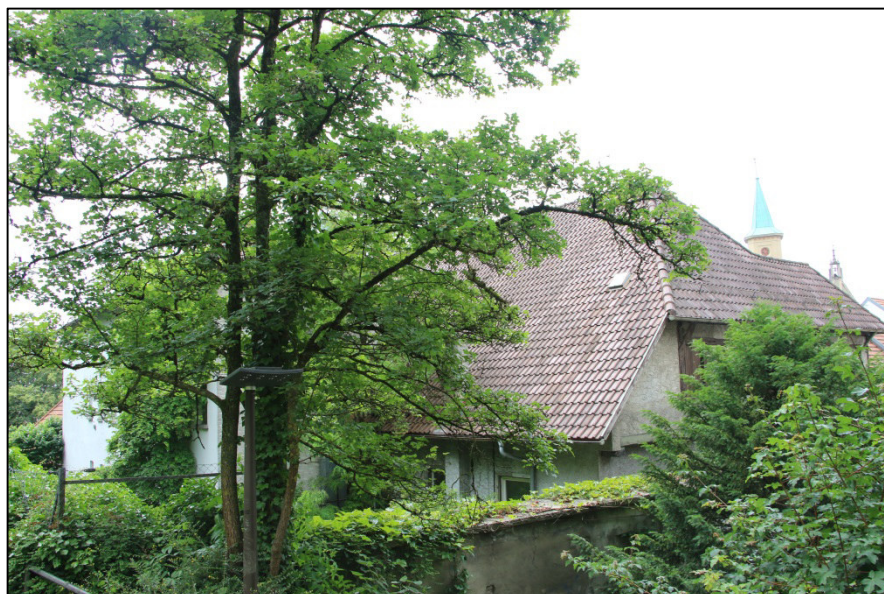
Abbildung 2 Blick auf das Gebäude vom Hang (oberhalb Burgstraße und unterhalb Gebäude Berufsakademie) aus. Rechts der historische Teil der Räuberhöhle und links im Bild der Anbau. Im Vordergrund ist die große und hohe Mauer und Torbogen mit der dichten Vegetation sichtbar. Foto Ramos 16.06.2015.
