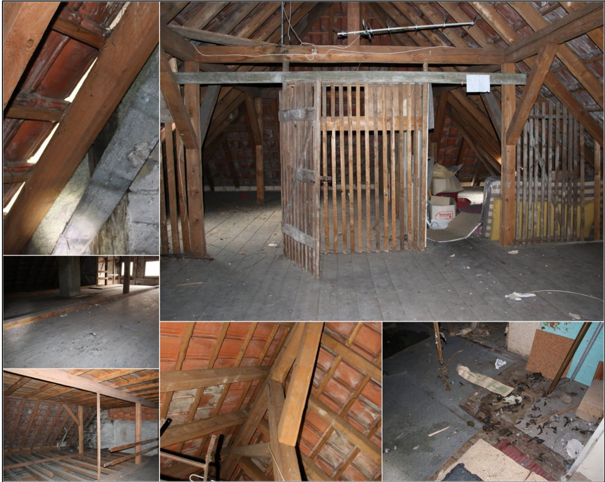
Abbildung 9 Dachstuhl Räuberhöhle. Fotos vom 16.06.2015.
