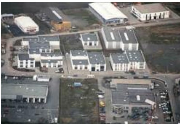
Abb. 34: Handwerkerzentrum Schiffahrter Damm in Münster
